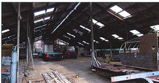
Figuur: binnenzijde van de te slopen loods.
