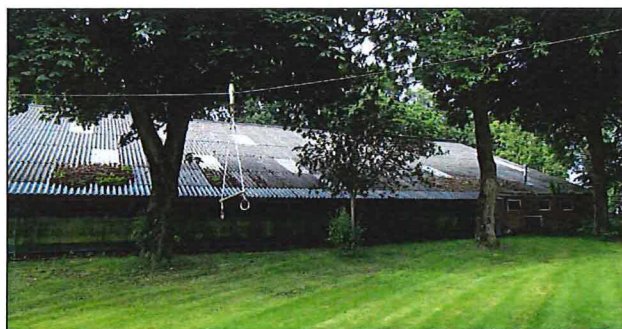
Figuur: noordzijde van de te slopen loods.
