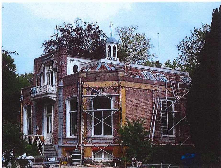
Foto uit 2010 (tijdens restauratie): achtergevel/rechter zijgevel
