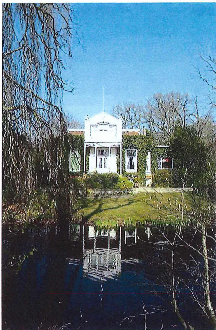
Foto uit 2003: voorgevel
