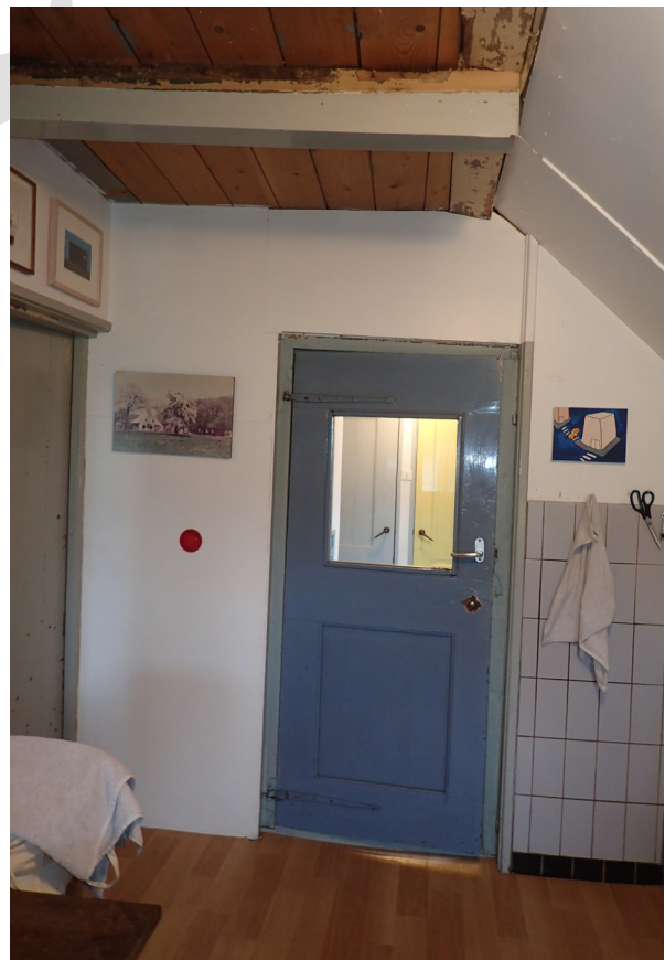
De keuken naar de voorgevel gezien, en naar achteren gezien. De plaat in de lengterichting, waar de dwarsbalken aan zijn opgehangen is op deze foto te zien.
