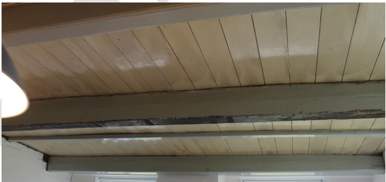
Balken voorkamer naar voren gezien (balk 1, 2, en 3 met profiel)
