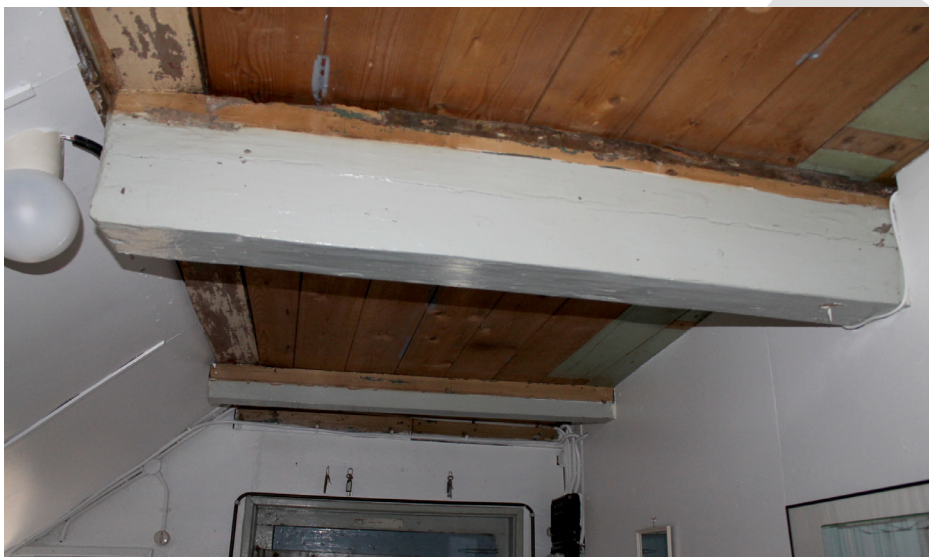
Keuken; de dwarsbalken zijn opgehangen aan de plaat in de lengterichting.
