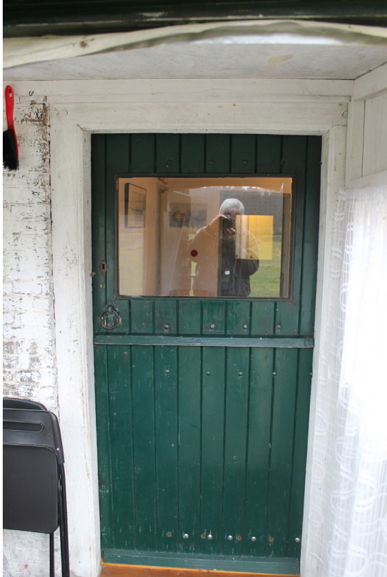
De voordeur met origineel kozijn met kwartbolle profilering.
