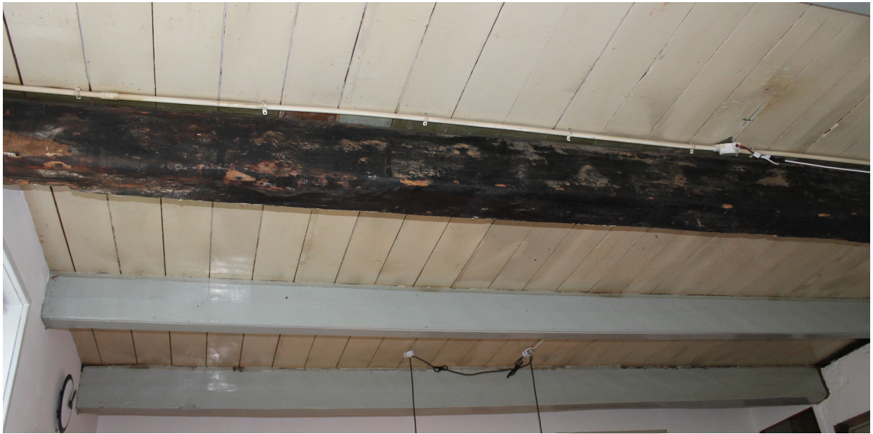
Balken voorkamer naar achteren gezien (balk 2, 3, 4) De balk met de zwarte kleur is balk 3 welke als enige doorloopt door naar de keuken.
