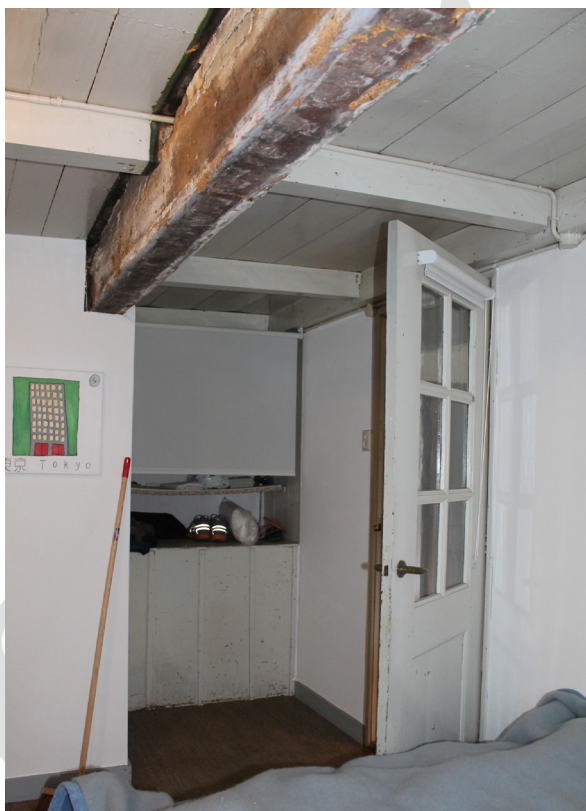
Slaapkamer: De nis en de dwarsbalk waarop lichtere balken in lengterichting liggen. De wand rechts dateert van 1967. Onder de balk sporen van een verdwenen muur.
