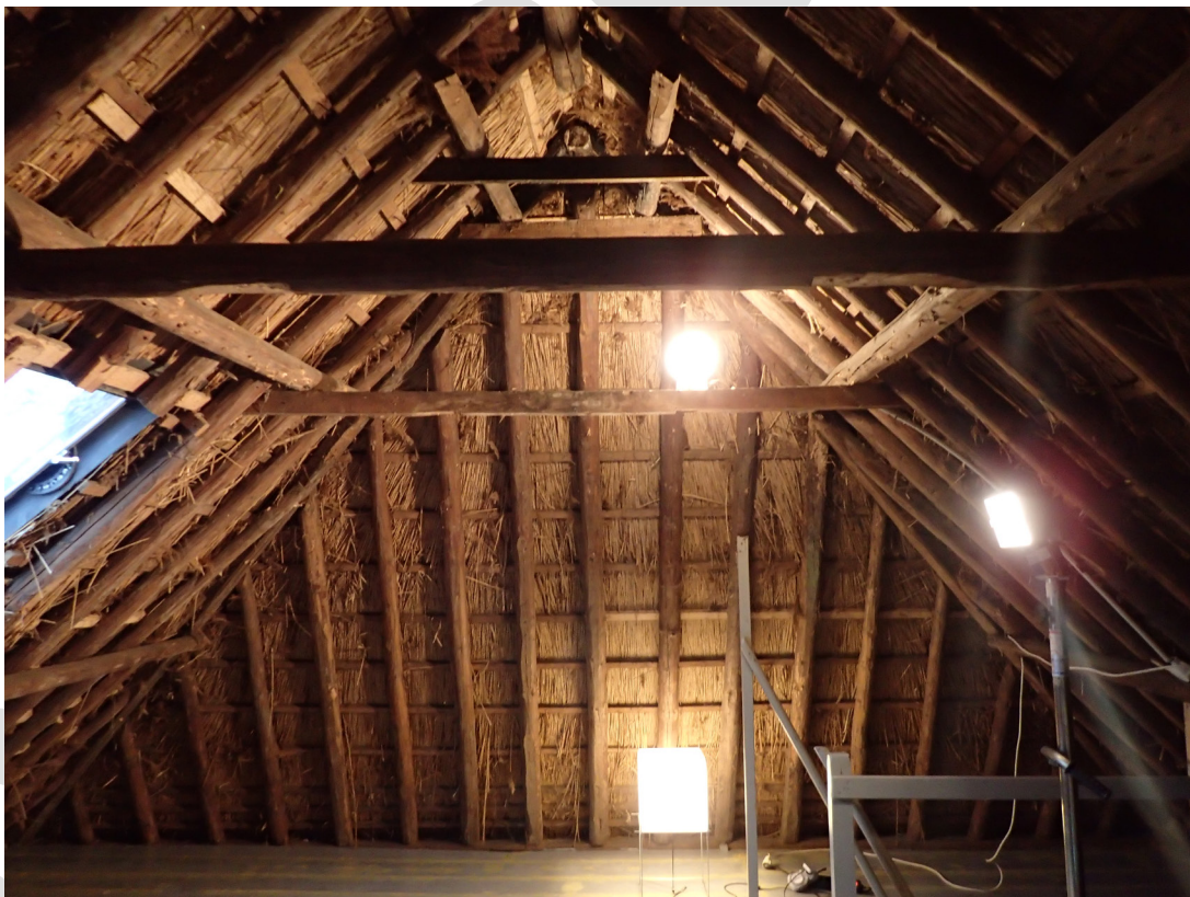
Zolder; de kap naar achter gezien. Om de vier sporenpaaren is een haanhout aanwezig.
