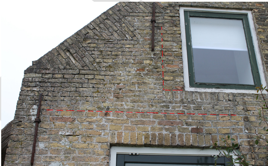
Voorgevel; met de rode lijn is de overgang in het metselwerk van grotere stenen naar kleinere friese geeltjes aangegeven. Ook de sporen van de vroegere plek van het venster in de top is aangegeven.
