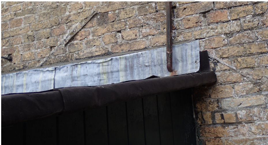
Boven het houten voorportaalje is de aftekening van de dakmoet zichtbaar waar zich een vroegere aanbouw tegen de gevel heeft bevonden.
