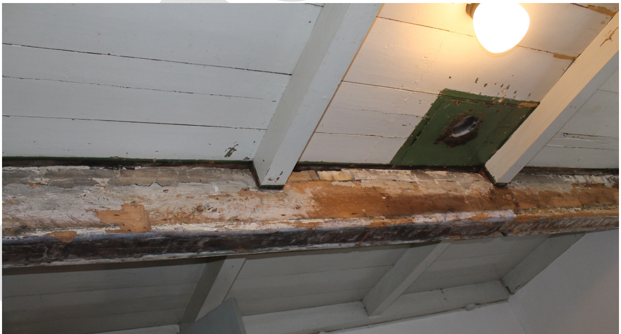
Balk 6, in de slaapkamer, in het achterste deel van het huis, en de kleinere naaldhouten balkjes in de lengterichting van het huis waarop oude vloerdelen liggen. In het plafond zit een gat voor een kachelpijp.
