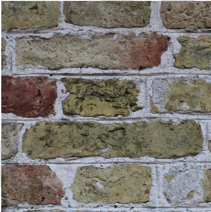
Voegwerk met voegstrepen en sporen van vroegere pleister.
