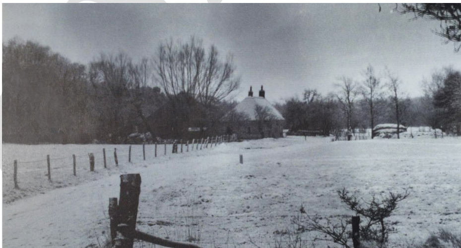
Op deze foto is te zien dat het huis nog twee schoorstenen had. Sporen hiervan zijn in de slaapkamer en in het dak nog aanwezig.
