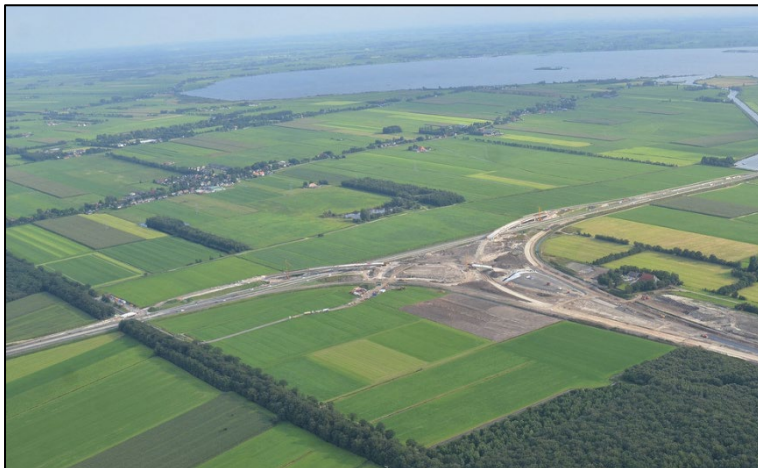
Figuur 22 Aansluiting A6-A7 in aanleg
