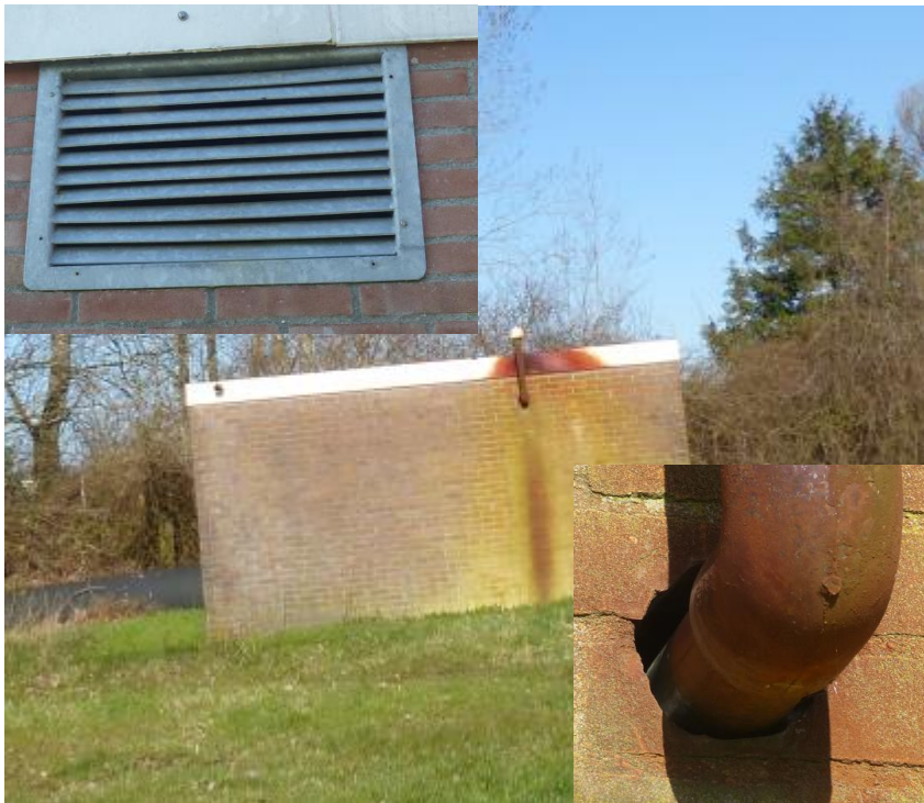
Foto 4 Een van de kleine, onbewoonde gebouwen in het plangebied. Vleermuizen kunnen in de gebouwen verblijven via de roosters en pijpen.
