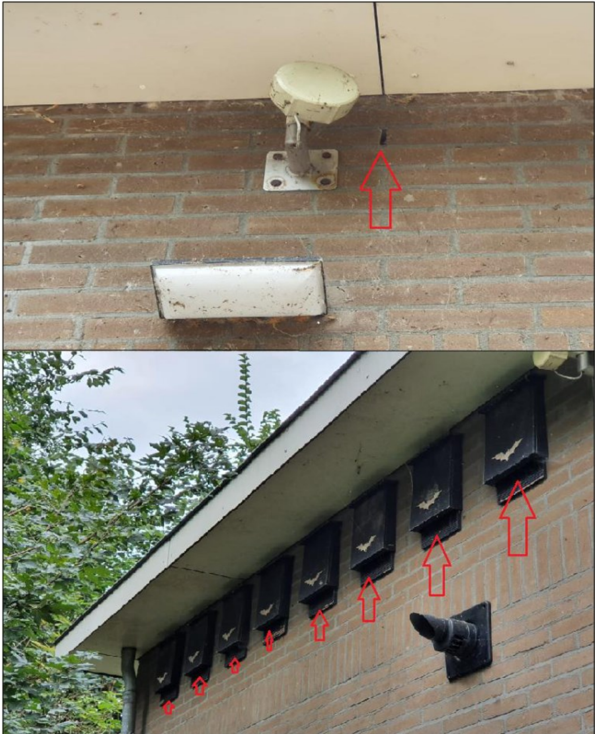
Figuur 2.3.: In de kazerne in het plangebied kunnen verblijfplaatsen van vleermuizen aanwezig zijn.
