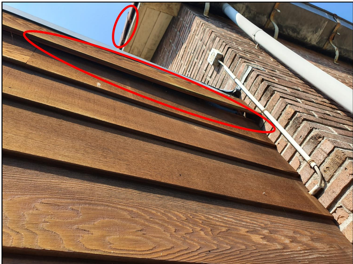
Figuur 2.2. In het plangebied is sprake van spouwmuren welke (deels) toegankelijk zijn voor vleermuizen.
