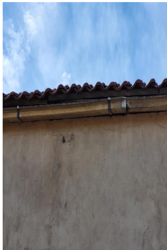
(1.1 Overzicht pannendak rechterzijde.)
