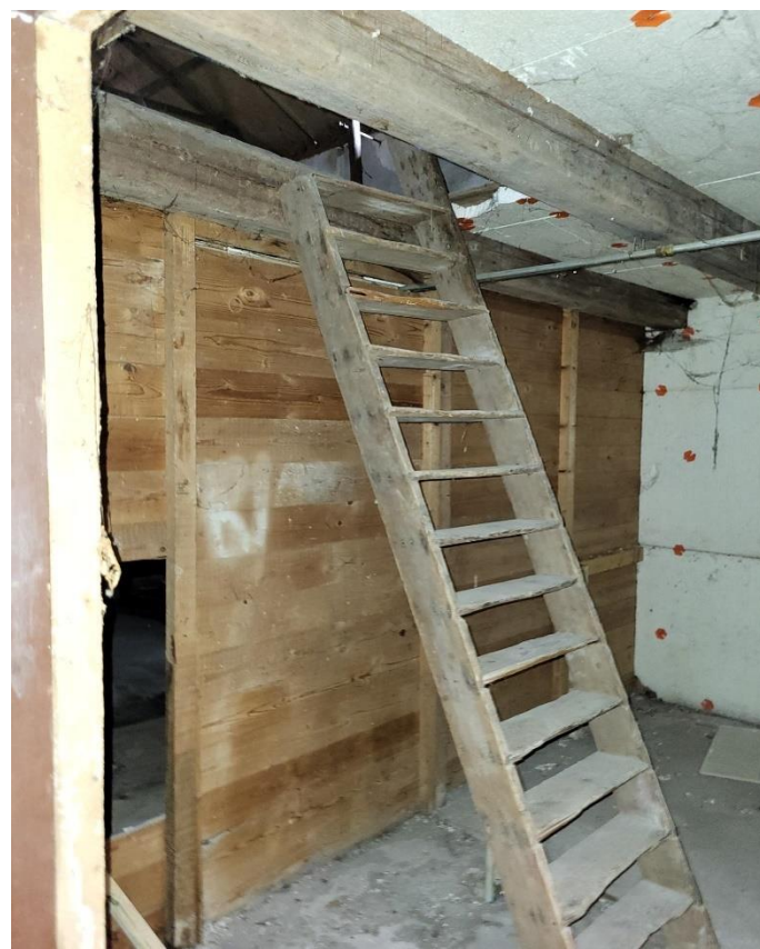
(0.8 Idem als 0.7 (binnenzijde benedenverdieping.)
