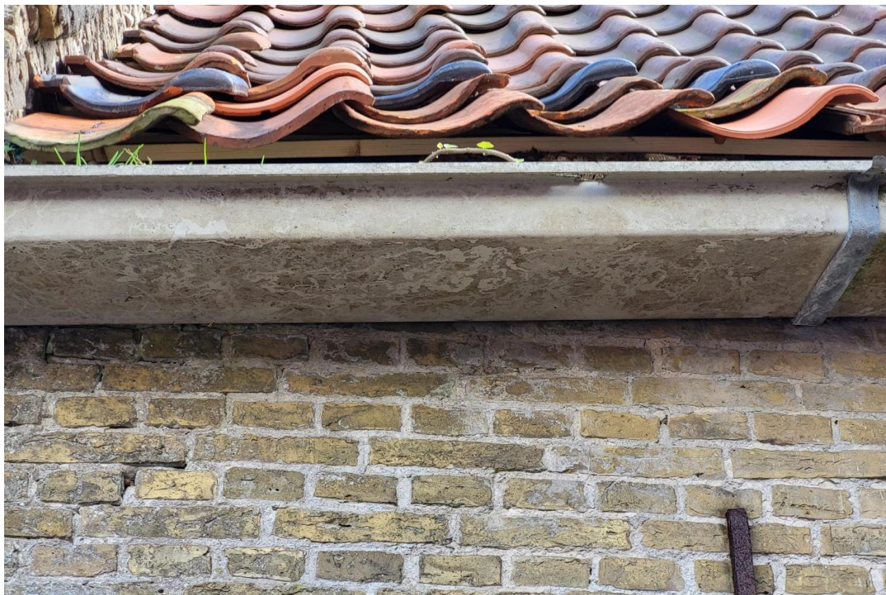
(0.9 Overzicht van pannendak. Foto genomen aan linkerkzijde planobject.)
