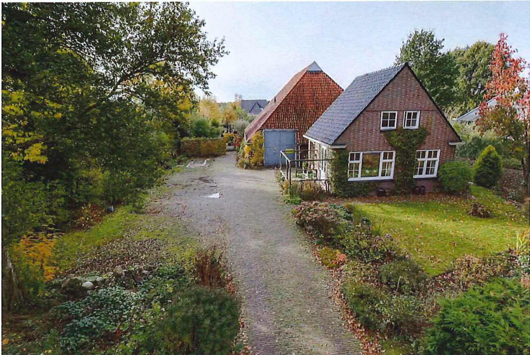
Bestaande situatie voorzijde (woning en schuur)
