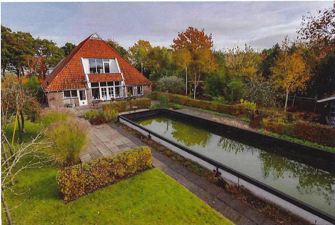
Bestaande situatie achterzijde (schuur)
