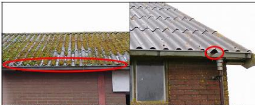
Figuur 2.2. Ruimten onder de gegolfde dakplaten zijn niet geschikt als nestlocatie voor de huismus.
