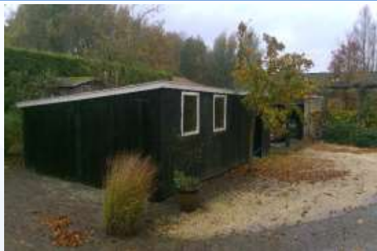
1 | Schuur met golfplaten
