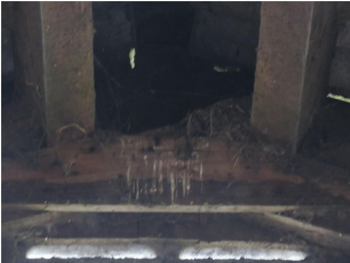
Figuur 2.4. Oud boerenwaluwnest in de te slopen paardenstalling.
