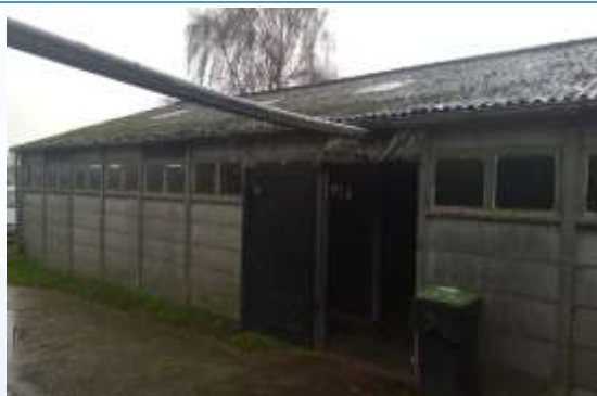
16 | Stopverf betonnen kozijnen
