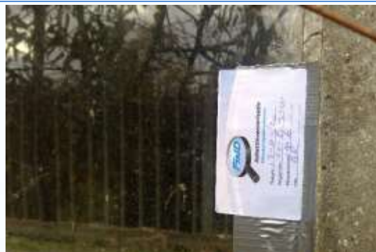
17 | Monstername stopverf betonnen kozijnen
