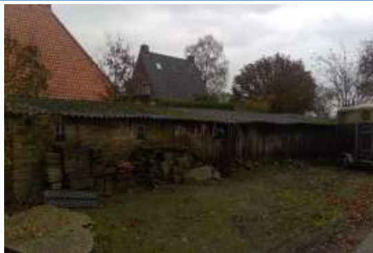
2 | Golfplaten op schuur
