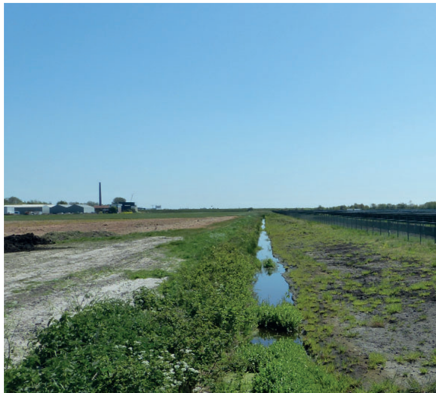
Watergang aan de noordzijde van het zonnepark. Deze watergang wordt (aan de linkerkant) verbreed t.b.v. watercompensatie.
