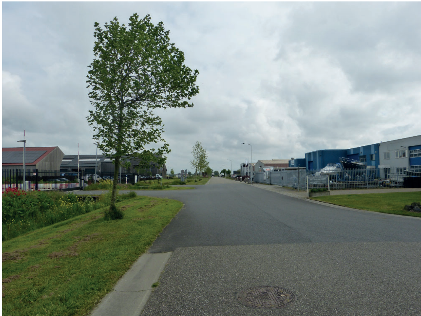
Bestaande situatie langs de Ossekamp.
