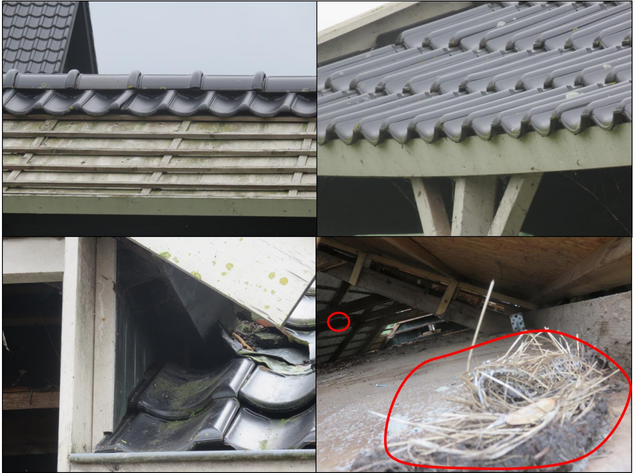
Figuur 2.2. Ruimten onder en tussen dak- en nokpannen binnen het plangebied evenals (resten van) nesten welke door de huismus gebruikt kunnen zijn/worden.
