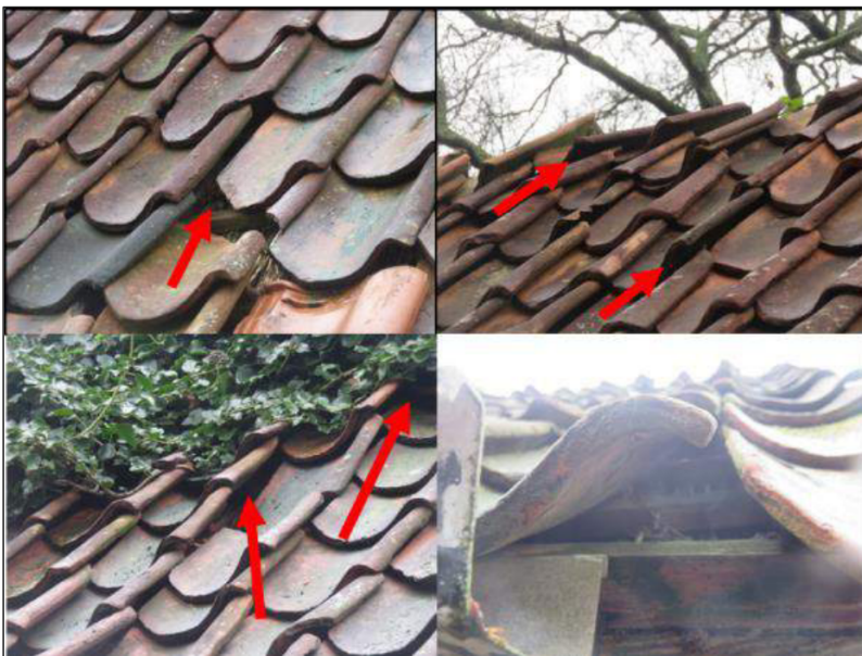
Figuur 2.4. Ruimten onder gegolfde dakpannen bieden in potentie geschikte verblijfplaatsen voor huismussen.
