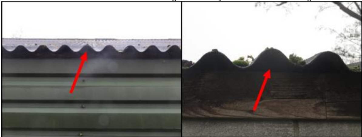
Figuur 2.3. Ruimten onder gegolfde dakplaten van de te slopen stallen en schuur. Deze ruimten zijn ongeschikt bevonden als verblijfplaatsen voor huismussen.
