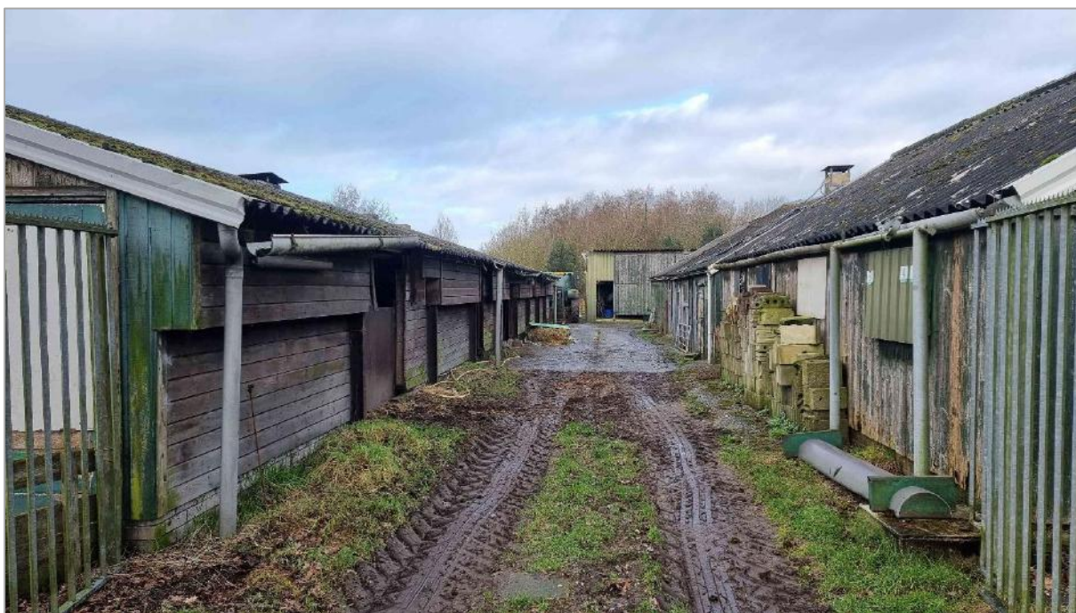
Impressie van de te slopen opstallen, de schuur rechts blijft staan. Foto richting noordwesten.
