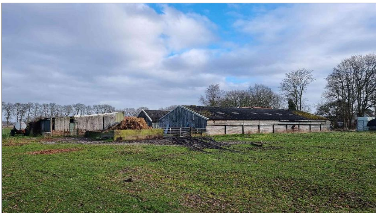
Impressie van de te slopen opstallen. Foto richting oosten.
