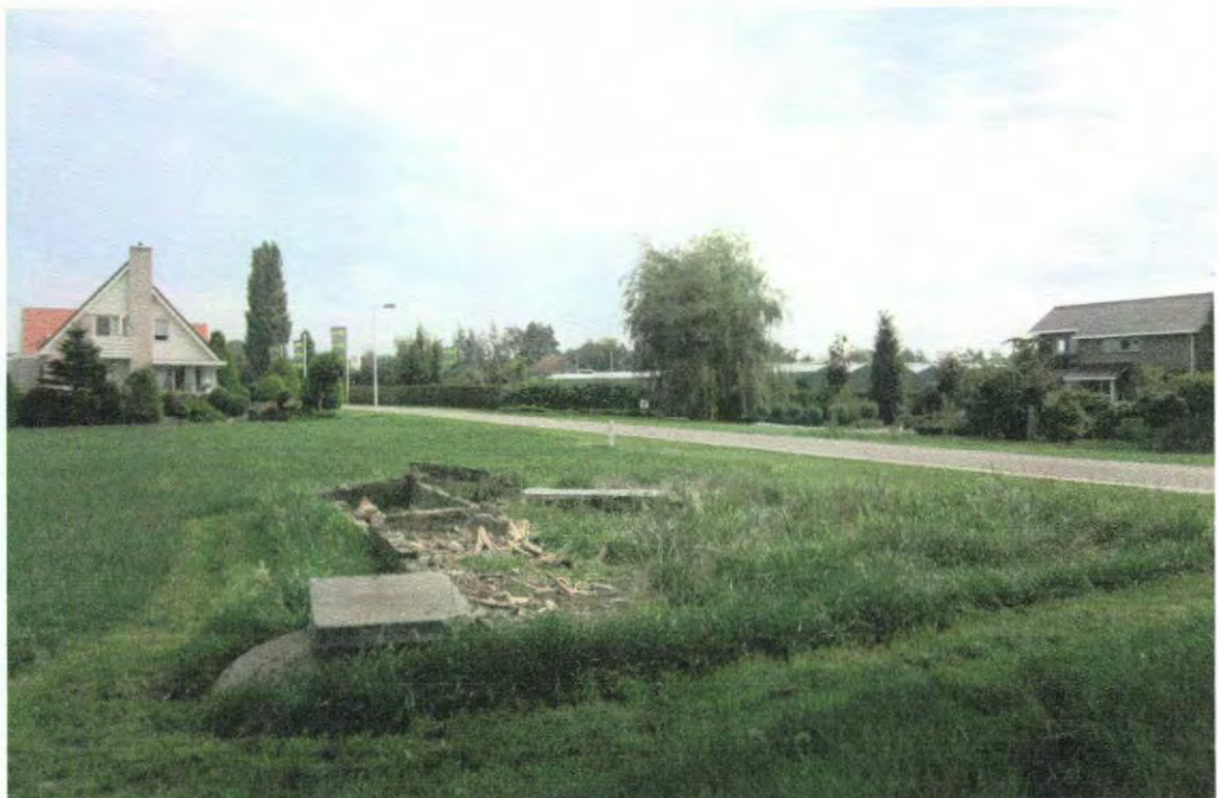
Huidige situatie met nog aanwezige fundering
