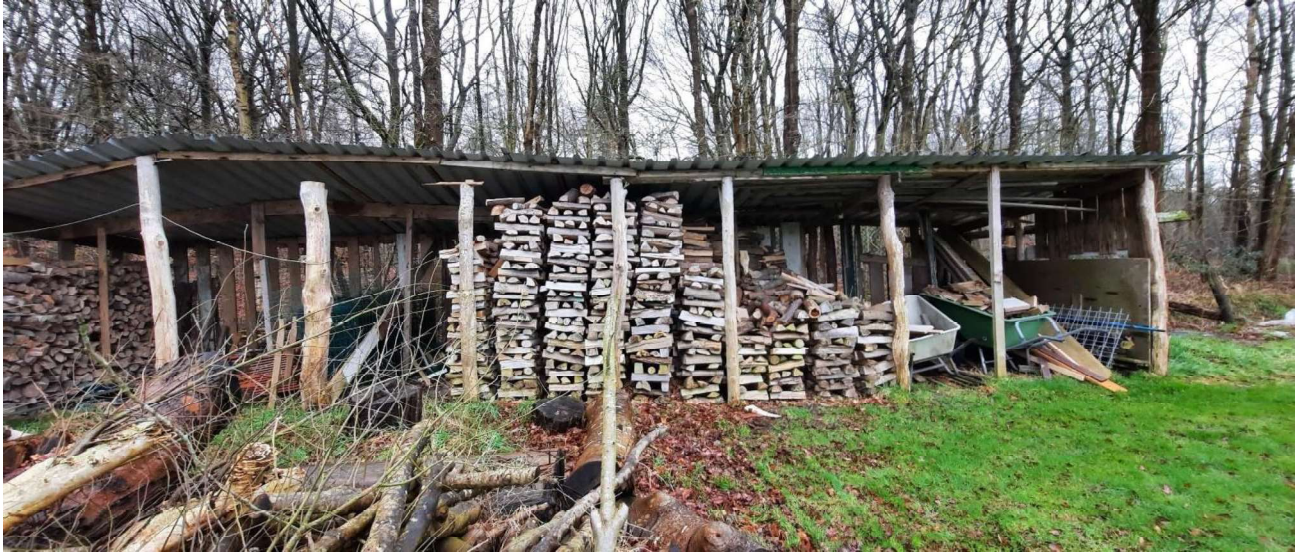
(Opslag voor haardhout, gelegen aan achterzijde terrein aan rechterkant)
