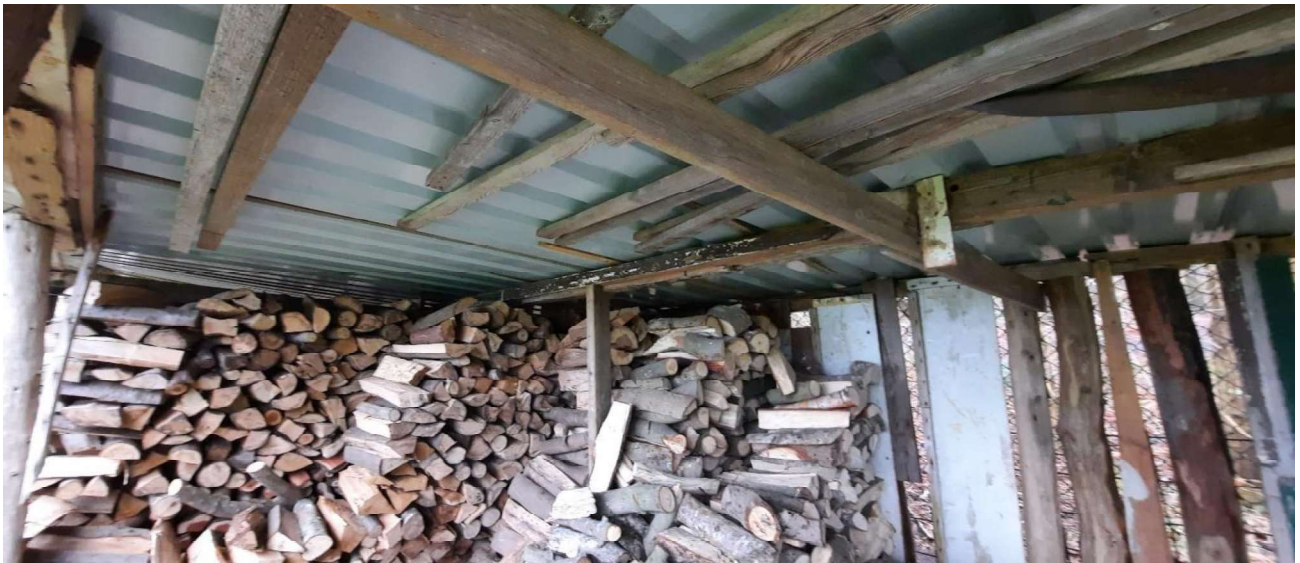
(Binnenzijde (dak) van opslag)
