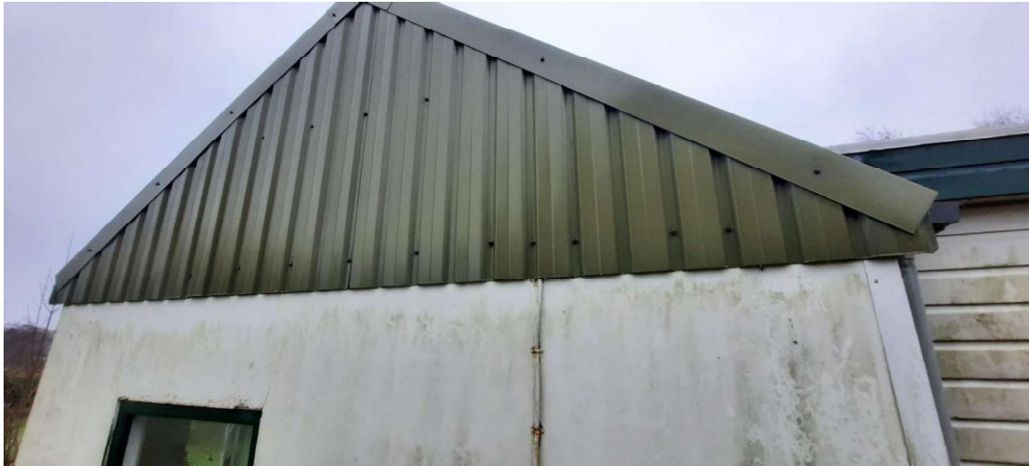
(wandbekleding muur aan voorzijde)
