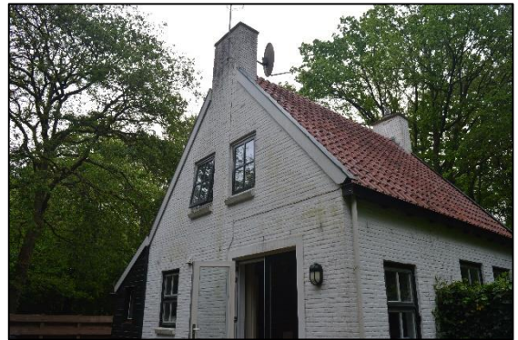
Afbeelding 2.3. Woning gezien vanaf noordwesten.
