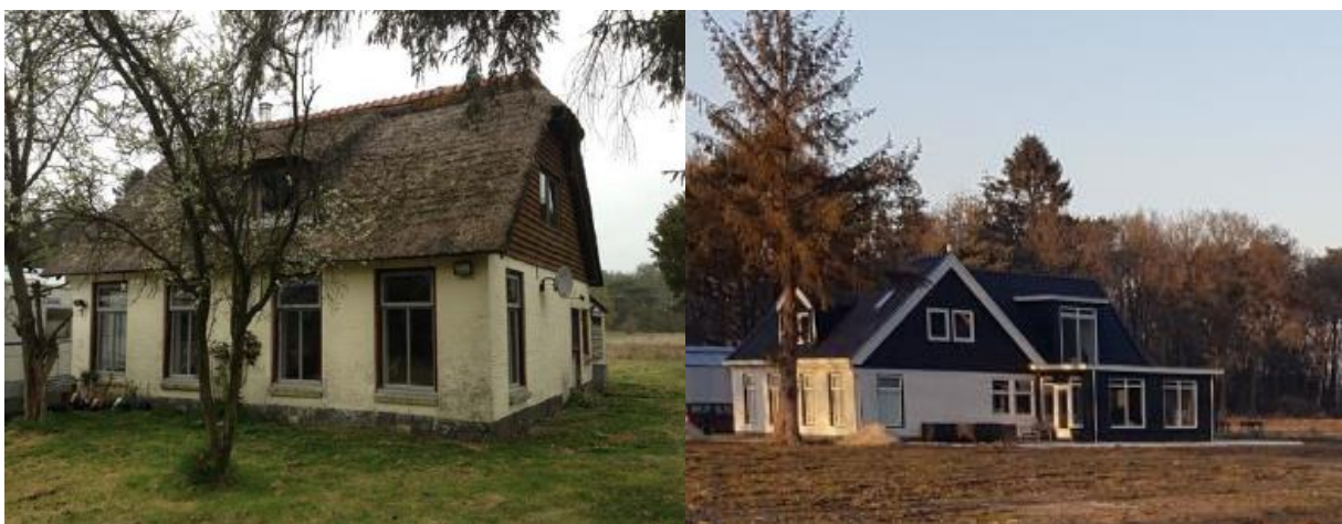
Fig. 5: de oorspronkelijke woning en de woning na de renovatie en uitbreiding van de woning (bron: Van der Wal)
