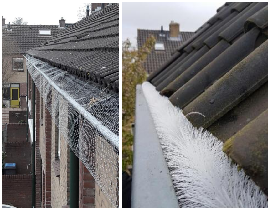
Figuur 6.3 Voorbeeld van het ontoegankelijk maken van de daken met gaas (linker foto) of spouwborstels in de dakgoot (rechter foto).
