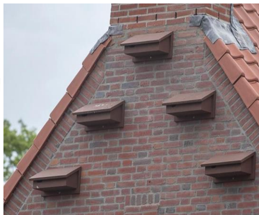
Figuur B2.6 Gierzwaluwnestkast type NK GZ 10 en impressie opgehangen gierzwaluwkast. Bron foto's: Vivara.nl
