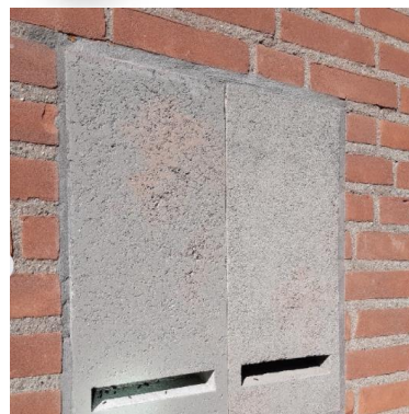
Figuur B2.3 Voorbeeld van twee geschakelde kasten. Bron foto: Unitura.nl
