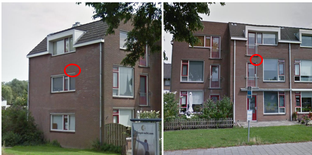
Figuur 4.2 Aangetroffen paarplaatsen ruige dwergvleermuis toegankelijk via open stootvoegen rechtsboven op de 1 e verdieping gelegen raam en deur respectievelijk (rood omcirkeld). Bron foto: Google Maps.
