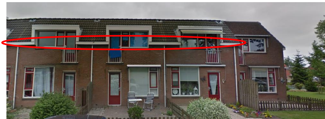
Figuur 4.2 Voorbeeld locatie aangetroffen nestplaats huismus onder de eerste rij dakpannen toegankelijk via de dakgoot (rood omcirkeld). Bron foto: Google Maps.
