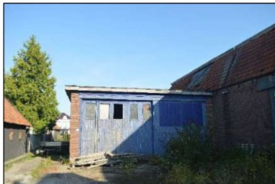
Aanbouw stenen pand aan zuidwestzijde plangebied, gezien vanaf oosten.
