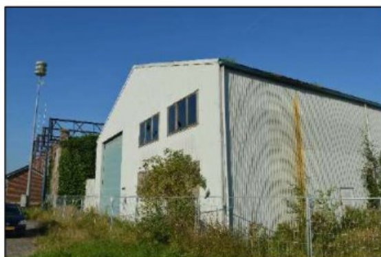
Loods met golfplaten dak ten noorden van de stenen panden, gezien vanaf noordoosten.
