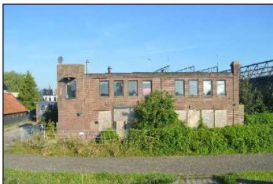
Stenen pand aan zuidwestzijde plangebied.
