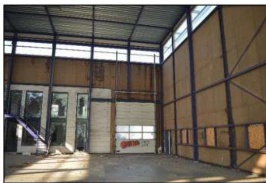
Afbeelding 2.11. Binnenzijde loods achter stenen panden aan het water, gezien vanaf noorden.
