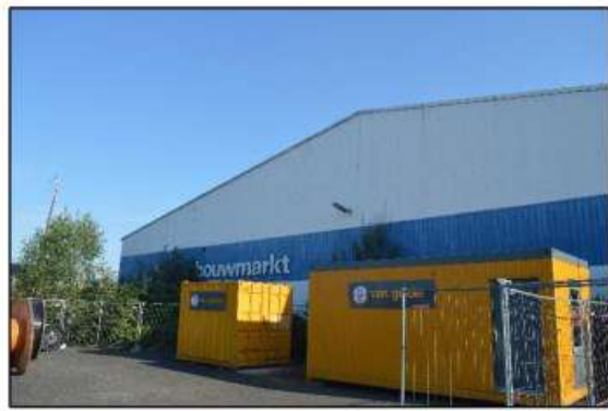
Afbeelding 2.17. Loods 'bouwmarkt' met opslag glasvezelbedrijf, gezien vanaf zuiden.
