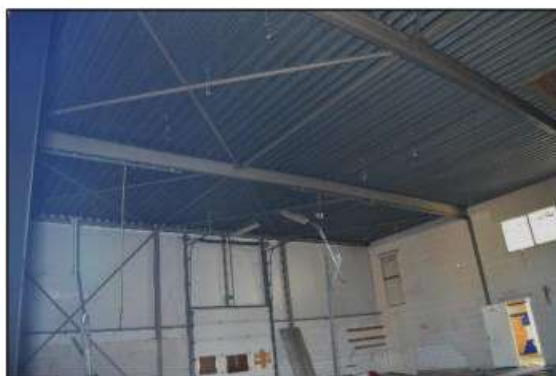
Afbeelding 2.10. Binnenzijde loods 'winterstalling Lemmer'.
