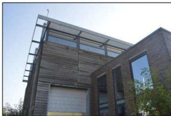
Afbeelding 2.13. Buitenzijde loods aan water met stenen pand, gezien vanaf zuiden.
