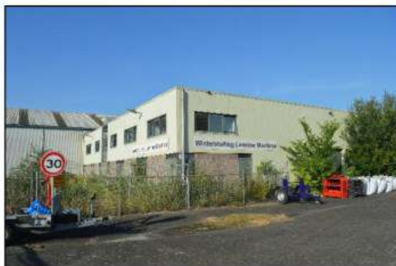
Afbeelding 2.8. Loods 'winterstalling Lemmer' ten noorden van stenen panden en loods, gezien vanaf noordoosten.
