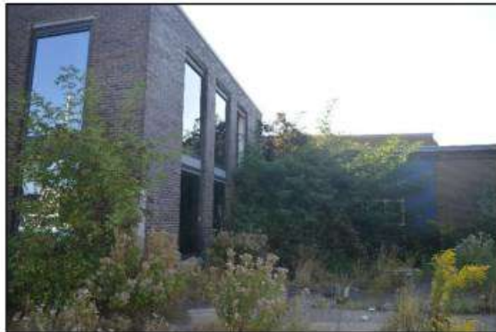
Afbeelding 2.14. Buitenzijde stenen pand, gezien vanaf westen.
