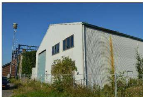
Afbeelding 2.7. Loods met golfplaten dak ten noorden van de stenen panden, gezien vanaf noordoosten.
