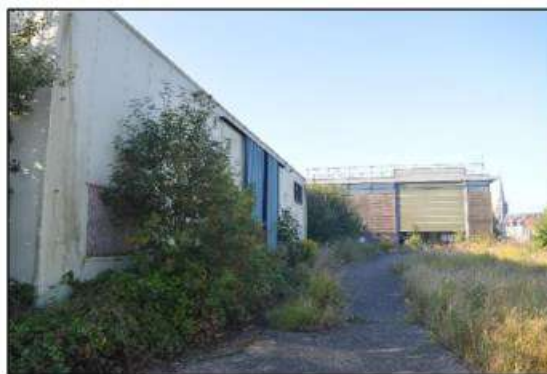
Afbeelding 2.9. Achterzijde loods 'winterstalling Lemmer' en loods achter stenen panden aan het water, gezien vanaf noorden.
