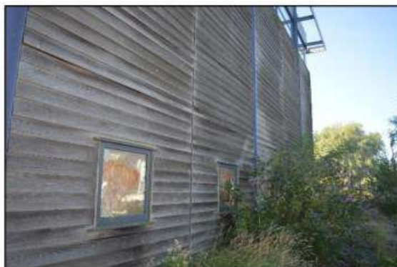
Afbeelding 2.12. Buitenzijde loods achter stenen panden aan het water, gezien vanaf noorden.
