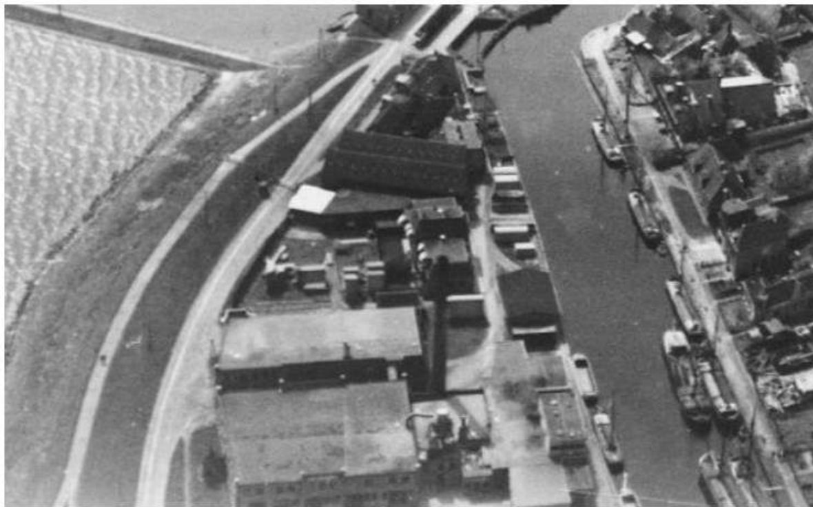
Foto uit de periode 1935-1940. De uitbreiding van het tweede bouwdeel is duidelijk te zien aan het kleurverschil in het dak.
