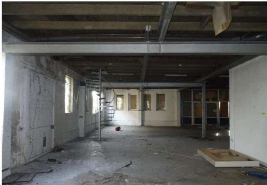
Interieur bouwdeel 1920. Alleen de balklaag en de buitenmuren herinneren aan de bouwtijd.
