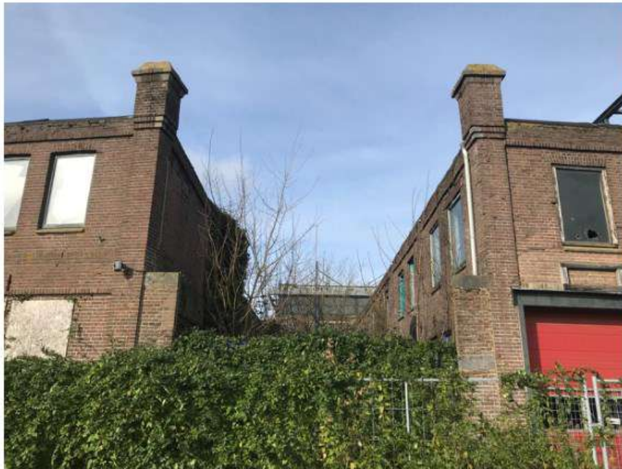
Zijgevels zuid. Rechts het oudste bouwdeel uit 1917. Links de uitbreiding uit 1920.
