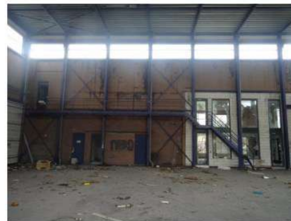
Impressie interieur en exterieur 1998.
