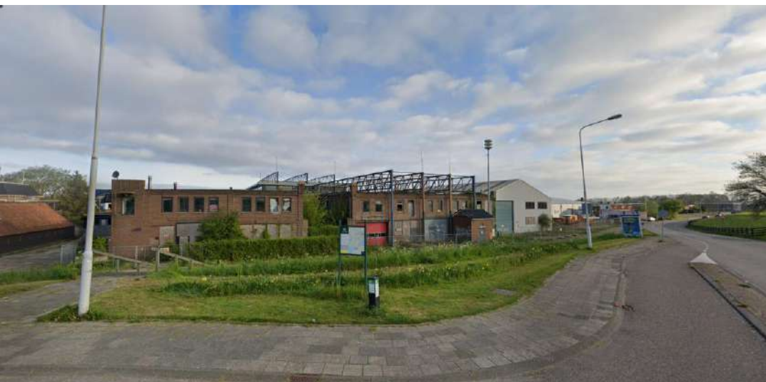
Zicht vanaf de Zeedijk. Oude fabriek dat op het projectgebied bevindt, is zichtbaar
