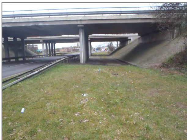
Foto 13: Omgeving viaduct A6
