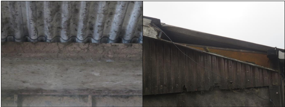
Figuur 2.3. Houten plaat aan de onderzijde van de gegolfde dakplaten op de stalling (links) en toegang tot de ruimte hiertussen (rechts).
