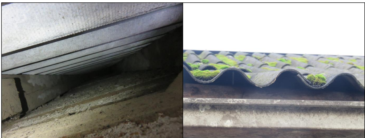
Figuur 2.4. Een isolerende ruimte onder de gegolfde dakplaten van de aanbouw (rechts) is toegankelijk via de uiteinden van de gegolfde dakplaten (rechts).
