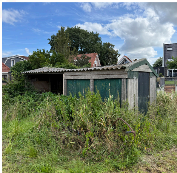
Figuur 7. Impressie oude verlaten schuur/stalling.
