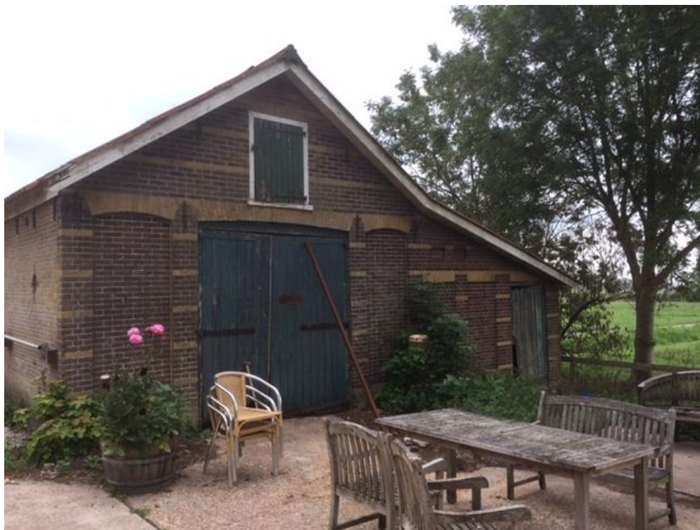
Fig. 5: De wagenberging met de oorspronkelijke voorgevel (bron: SGF-Advies)
