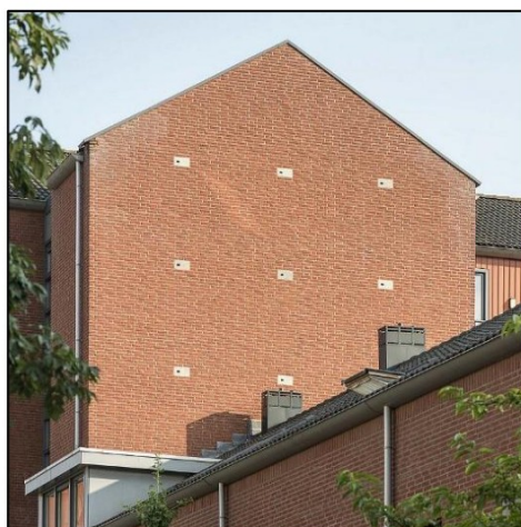
Afb 9 + 10: Gierzwaluwkasten ingemetseld (worden ook gebruikt door Huismussen)
