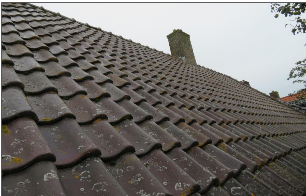
Afb 8: Pannen in de dakvlakken liggen strak
