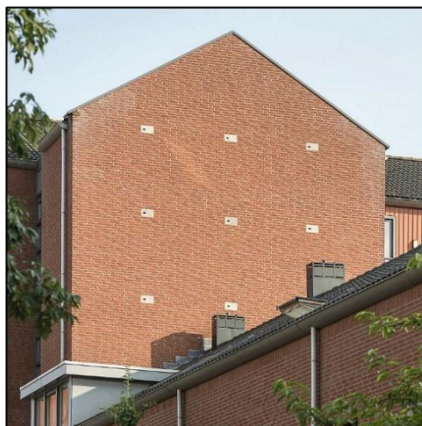
Afb 19 + 20: Gierzwaluwkasten ingemetseld (worden ook gebruikt door Huismussen)
