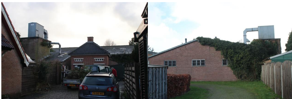
Impressie van het plangebied gezien vanaf de toegangsweg in het oosten en gezien vanaf het zuiden (17 januari 2019)
