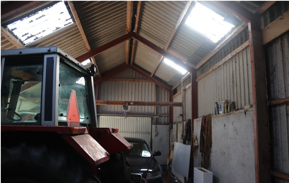
Figuur 3.2: Garage met enkelvoudige wanden en dak
