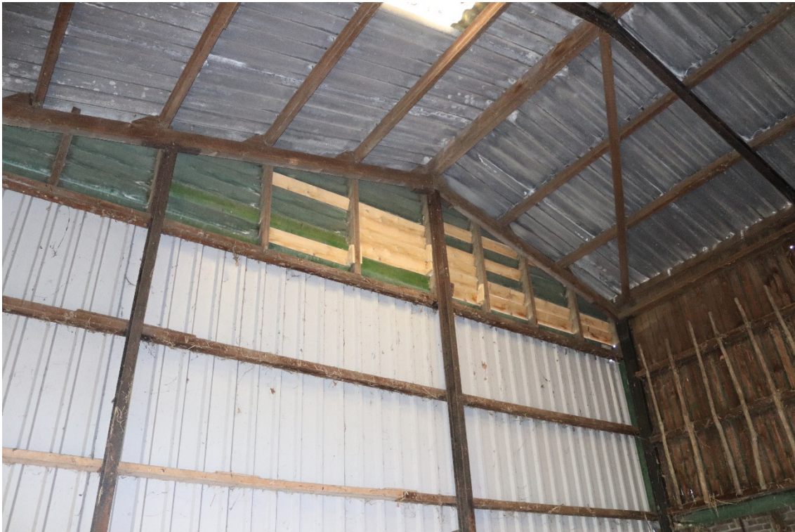
Figuur 3.3: Voormalige hooischuur met enkelvoudige wanden en dak
