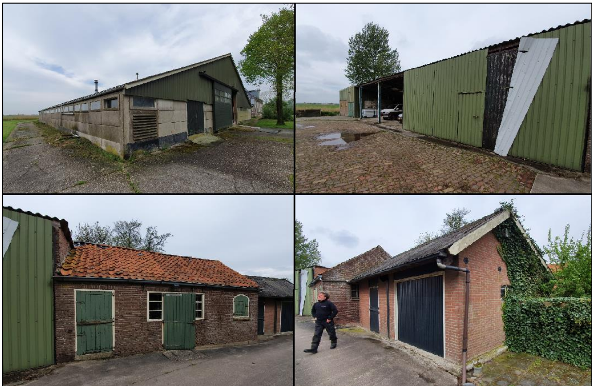
Figuur 1.1.: Van links naar rechts en van boven naar beneden. De loodsstal, een bijgebouw dat grotendeel is opgetrokken uit metalen profielplaten., een bijgebouwtje met een dak dat is afgedekt met gegolfde dakpannen en een bijgebouwtje dat is opgetrokken uit bakstenen en waarvan het dak is afgedekt met golfplaten.
