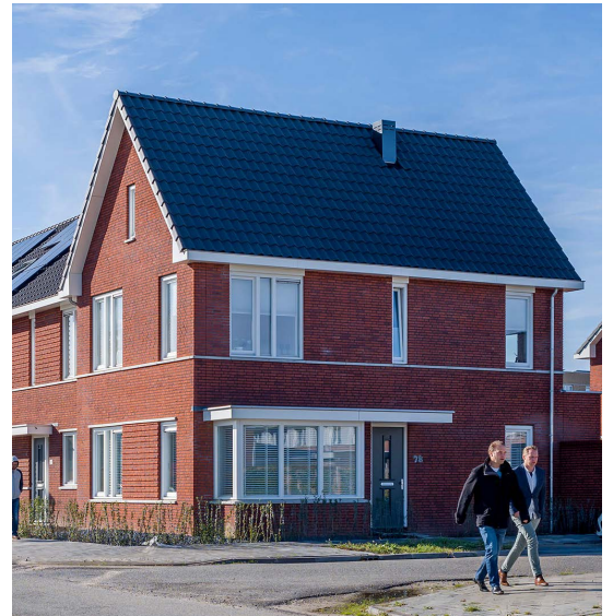
Kopgevels zijn representatief, voorzien van baksteen, hout of een combinatie
