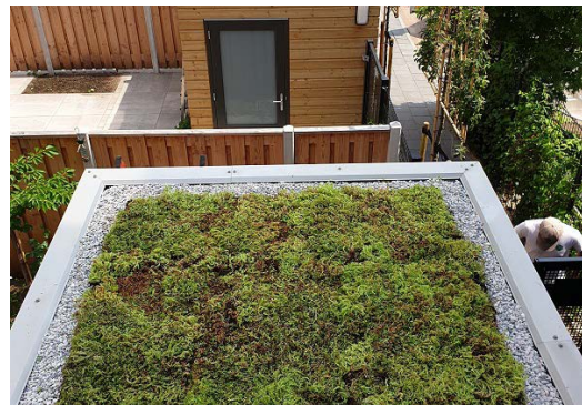
Toepassen groen (sedum) dak
