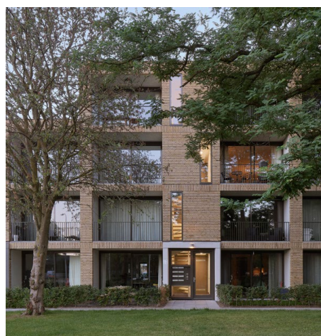
Buitenruimte afgeschermd met lage haag
