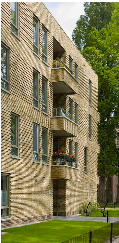
Hoogwaardige afwerking balkons afgestemd op de architectuur van het gebouw
