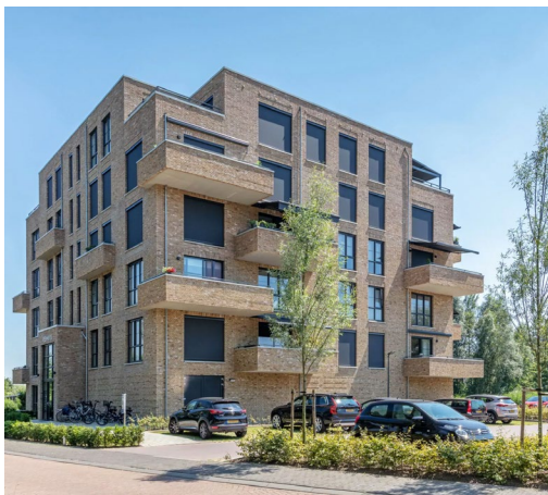
Balkons voorzien van metselwerk
