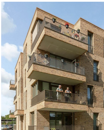
Balkons metselwerk en hekwerk
