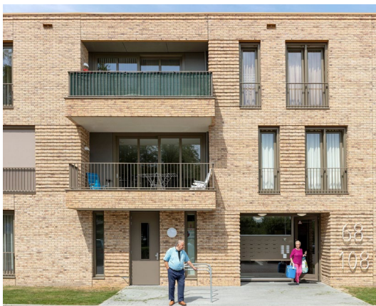
Balkons afgestemd op de architectuur van het gebouw
