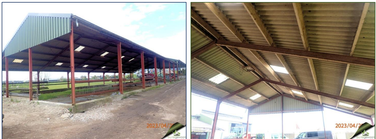
Figuur 5. Foto impressie opstal nr. 1 – voormalige stal zonder wanden
