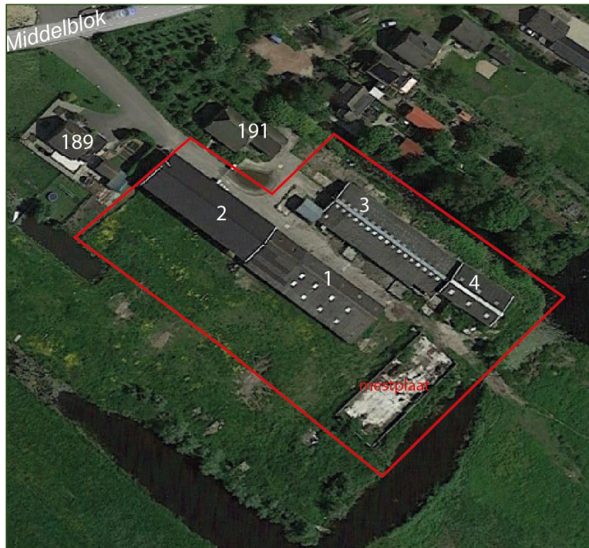
Figuur 4. Nummercodering van de betrokken opstallen, beplantingen, etc. t.b.v. beschrijvingen
