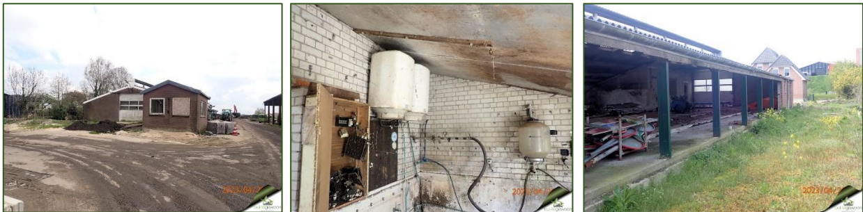
Figuur 7. Foto impressie opstal 3 – voormalig tanklokaal en werkplaats
