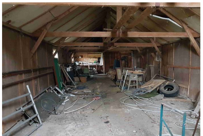
Foto 4: voormalige kalverschuur, inpandig
