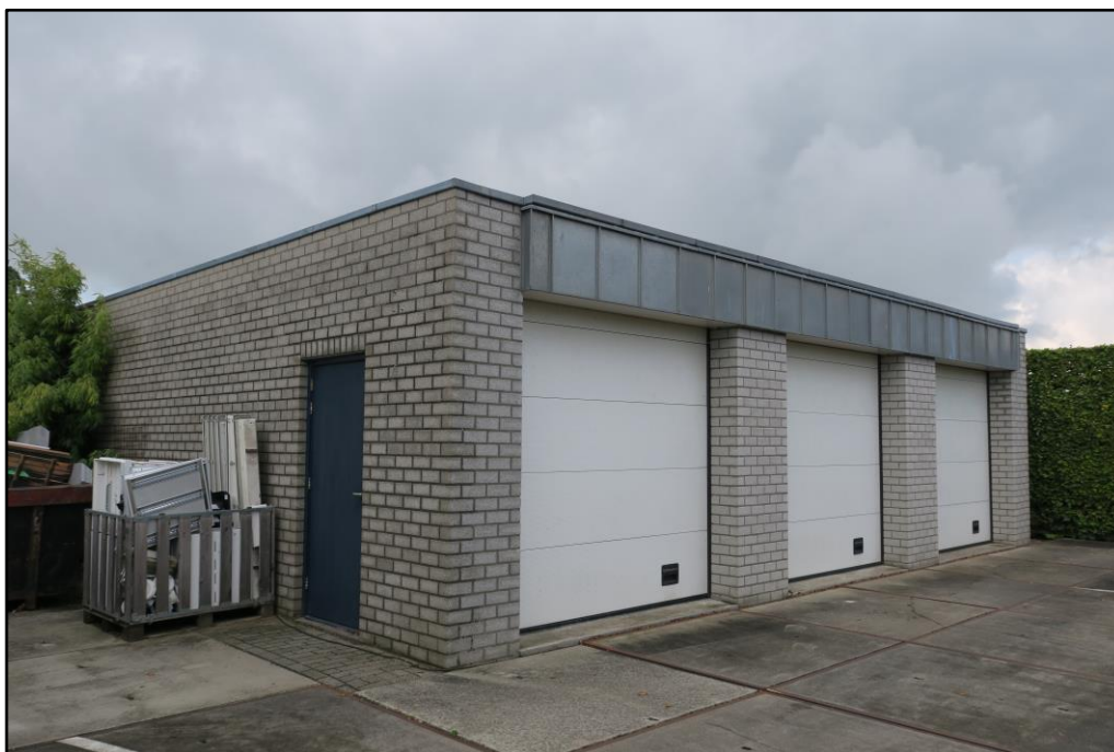
Figuur 2 De garage biedt geen potentie voor gebouwbewonende vleermuizen.
