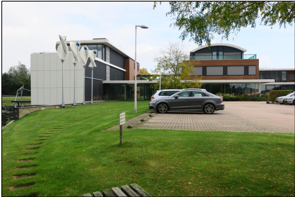
Figuur 4 De planlocatie is gelegen op een bedrijventerrein.
