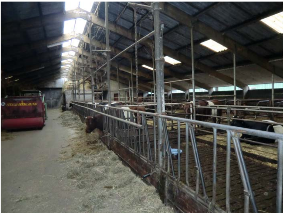
Interieur van de ligboxenstal. Te zien is de voergang die zo breed is dat een tractor met runvoer / kuilgras er door kan rijden.
