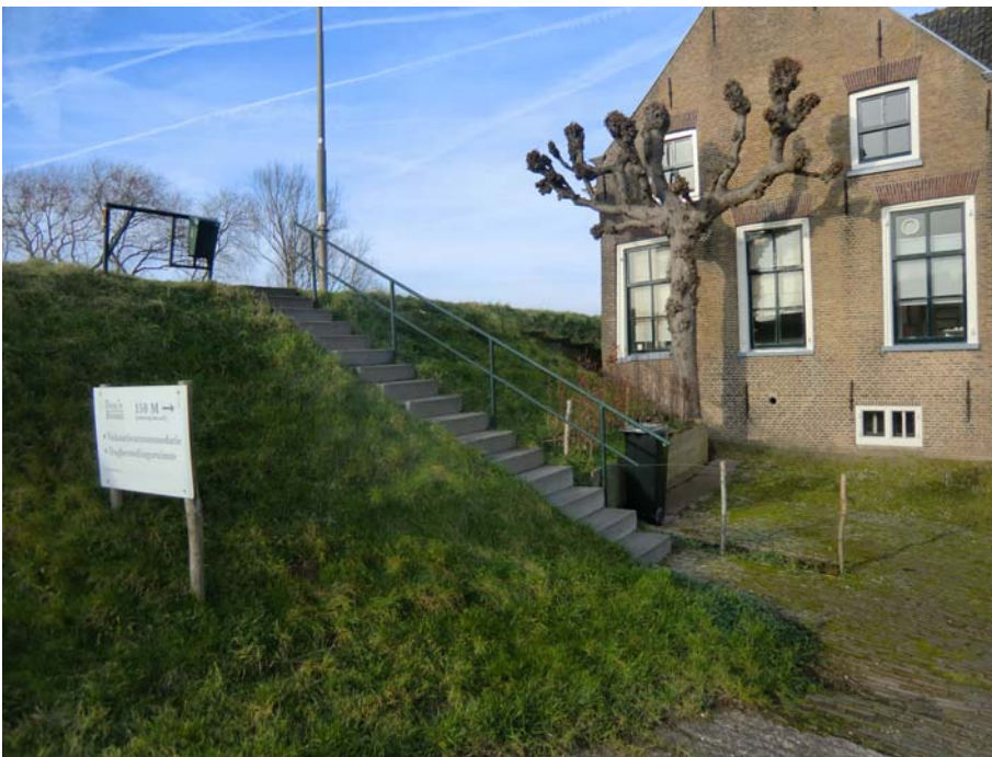
De rechter zijgevel van het voorhuis. In de gevel bevindt zich een authentiek dubbel keldervenster. Dit keldervenster is mogelijk ouder dan de rest van het gebouw. Het venster is afwijkend en zit niet op één lijn met de overige vensters in de gevel.
