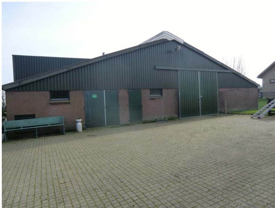
Voorgevel van de ligboxenstal. De wanden bestaan voor het grootste deel uit metselwerk in halfsteens verband met daarboven metalen platen in damwandprofiel. De grote schuifdeuren geven toegang tot de voergang. De kleinere deuren geven toegang tot de melkstal en het melklokaal.
