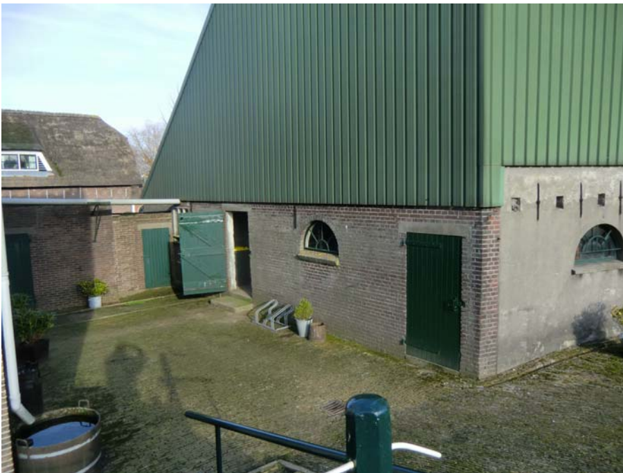
Ook in de zone tussen hoofdgebouw, grote schuur en spoelhuis is klinkerbestrating aangelegd.
