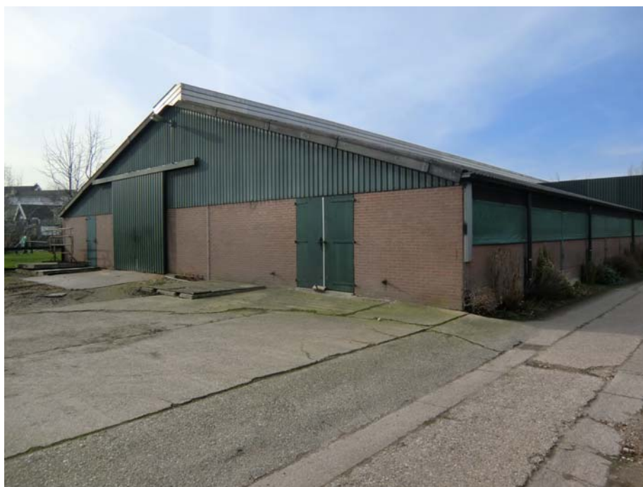
Achterzijde van de ligboxenstal. De grote schuifdeur komt uit bij de voergang. De andere deuren geven toegang tot de stallen. Het dak is bedekt met golfplaten. De beide zijgevels zijn voorzien van grote ventilatieopeningen, afgedekt met windbreekdoek.
