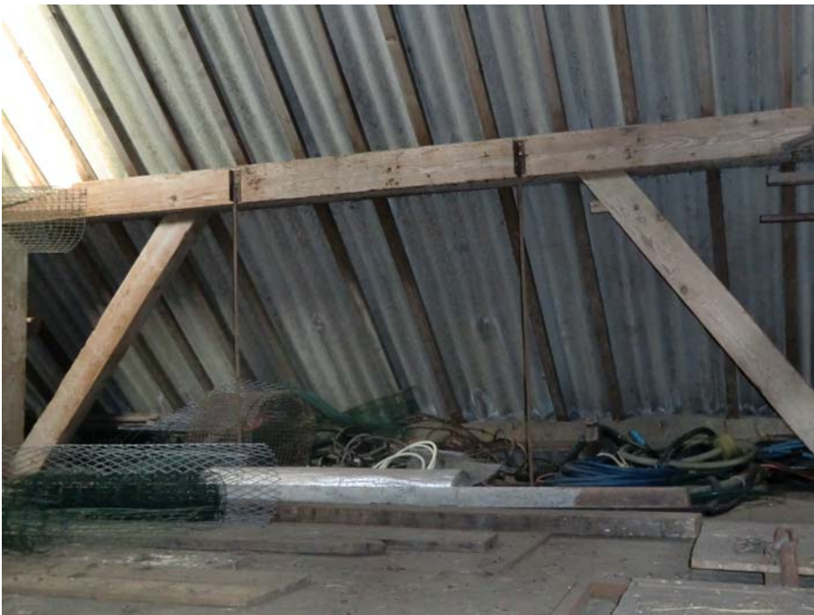
De vloerconstructie is met trekstangen versterkt die zijn bevestigd aan de gebintdebalk.
