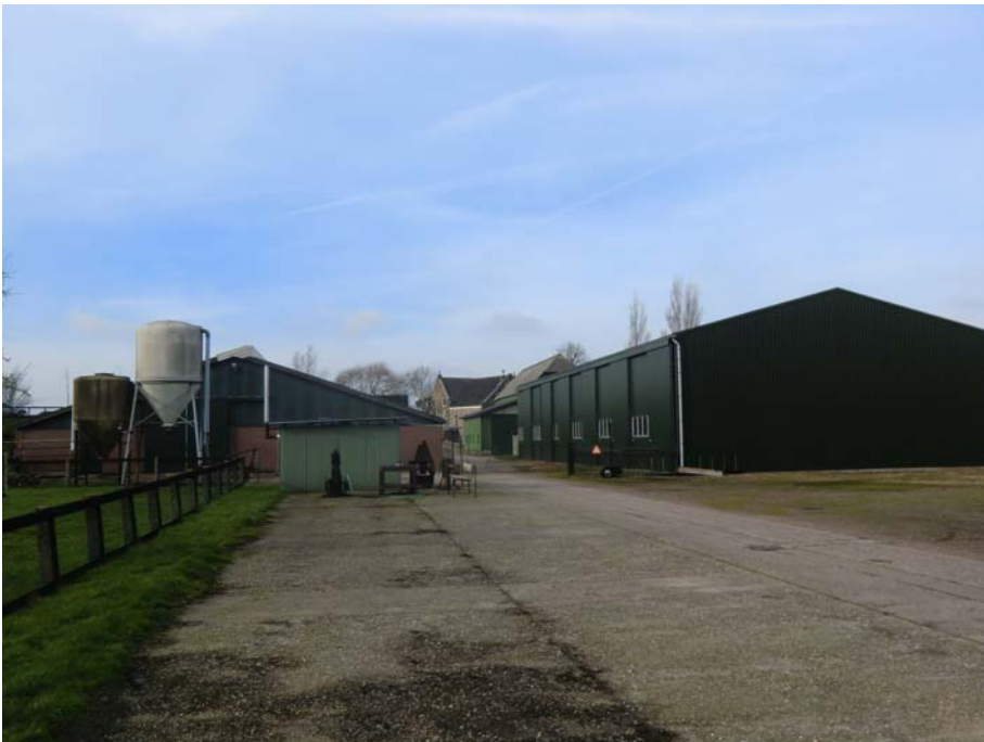
Achtergevel van de spantenloods.
