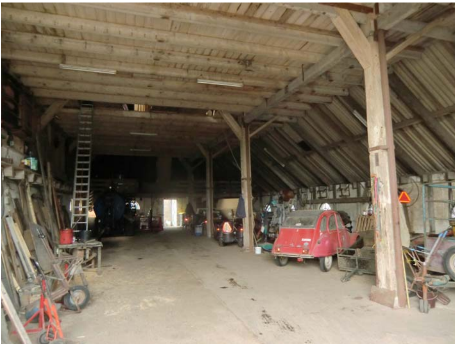
De constructie bestaat uit hoge gebintstijlen. De houten gebintstijlen zijn versterkt met ronde metalen buizen die zijn toegepast als kolommen voor de ondersteuning van de grote overspanning.
