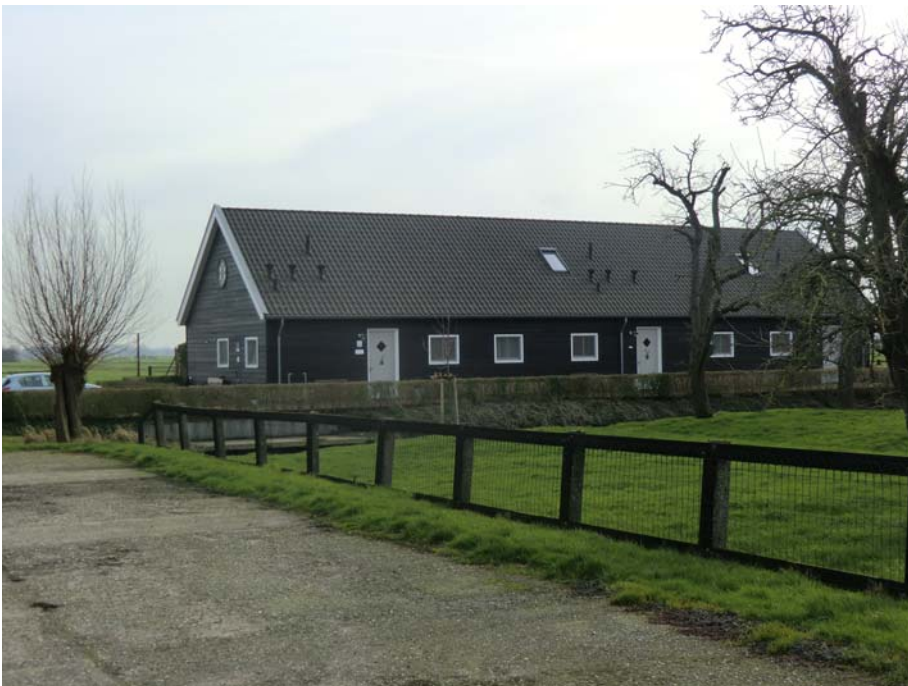
Voorgevel en linkerzijgevel.
