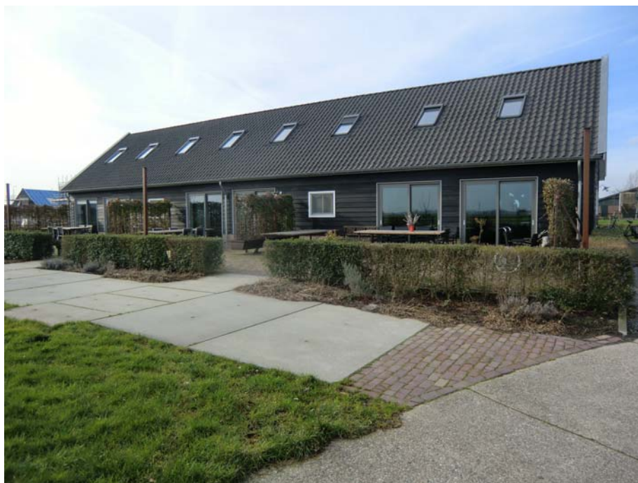
Achtergevel, aan de zijde van de polder.
