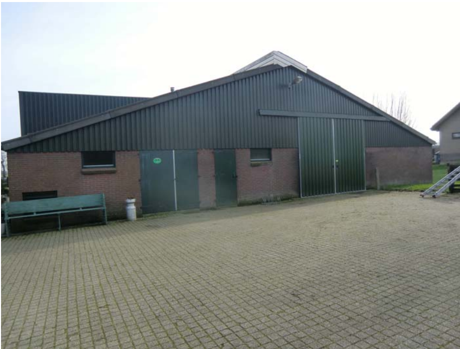
Voor de ligboxenstal liggen betonklinkers.
