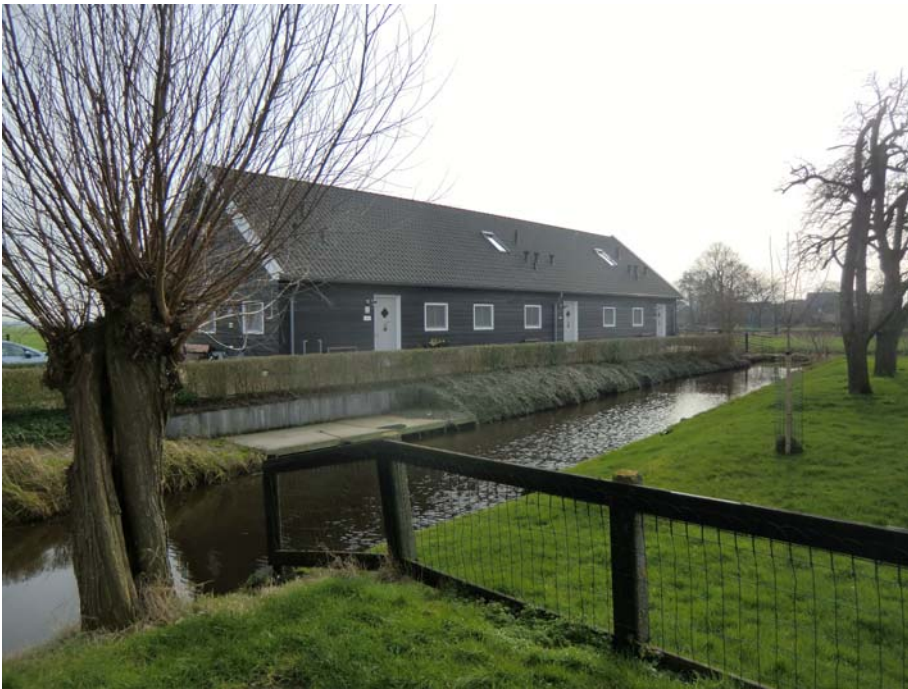
Voorzijde (erfzijde) van het gebouw met de toegangsdeuren. Door materiaal- en kleurgebruik past het object in zijn omgeving en bij het boeren erf.
