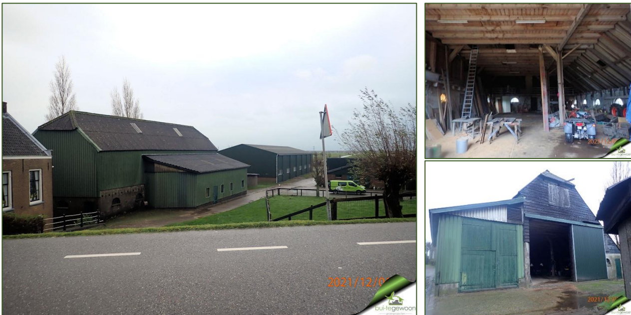
Figuur 5. Opstal 1 betreft de werkplaats achter de dijkwoning
