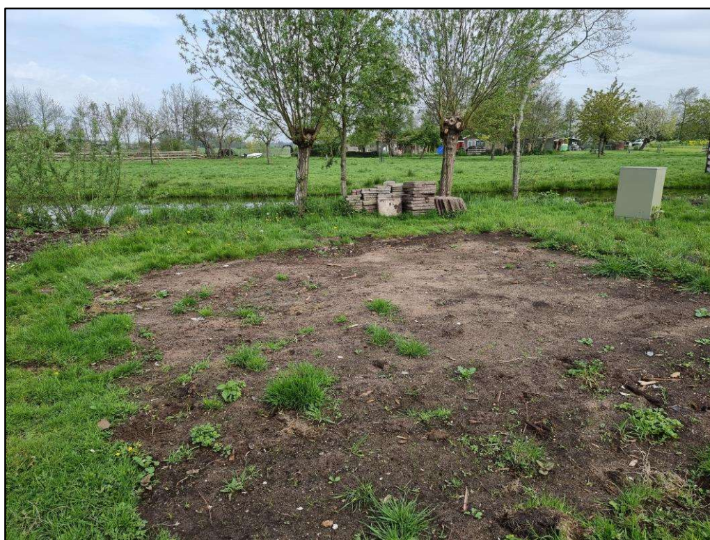
Figuur 3 Bouwlocatie van het te realiseren zomerhuis.
