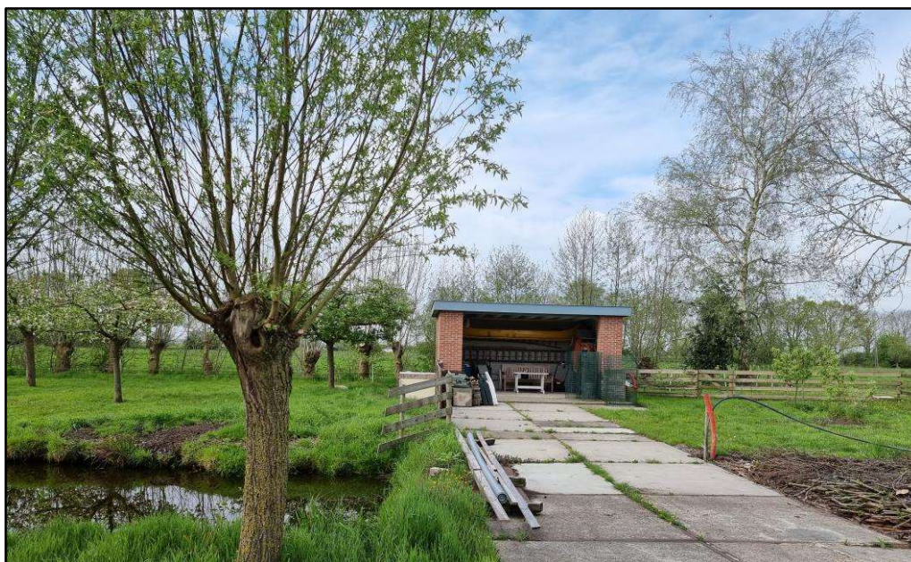
Figuur 4 De schuilgelegenheid gelegen aan de westelijke zijde van het perceel.
