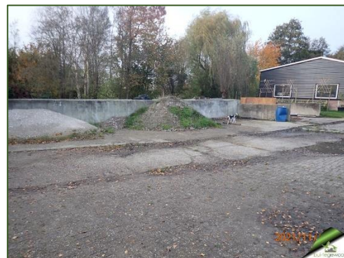
Figuur 10. Kuilplaten en mestopslag
