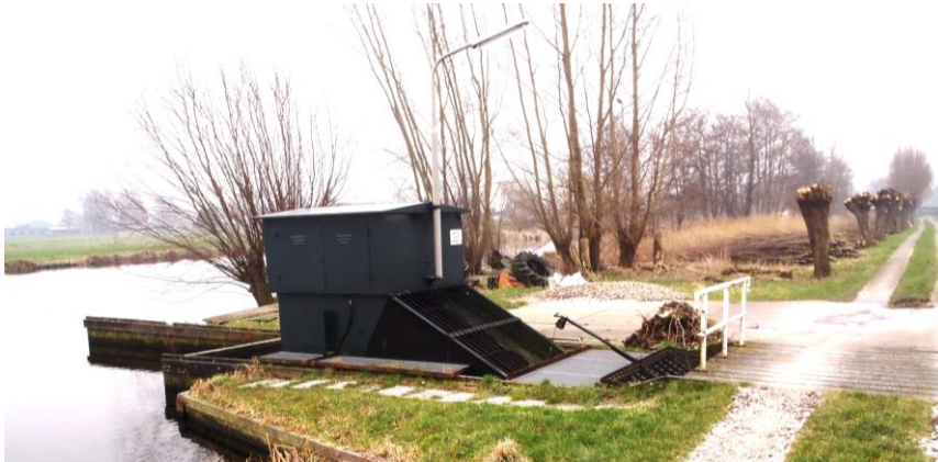
Afbeelding 1.1 Gemaal Achterbroek (bestaand)
