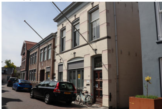
Voormalig gemeentehuis vanuit oostelijke richting.
