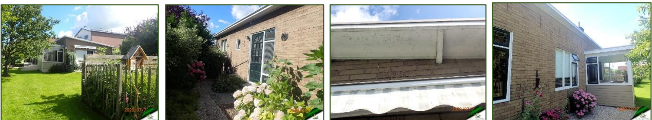
Figuur 7. Foto impressie opstal nr. 1 – te slopen woning
