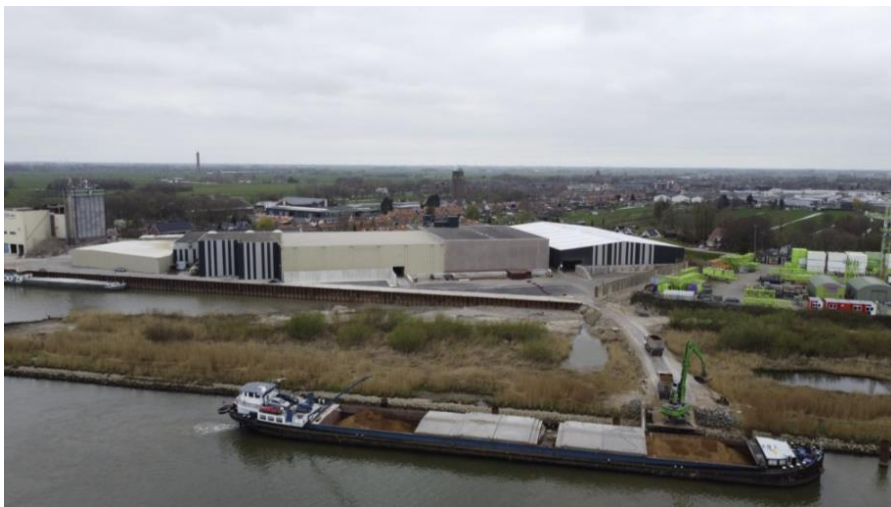
Totaaloverzicht 2021 met rechts nieuwe opslagloods
