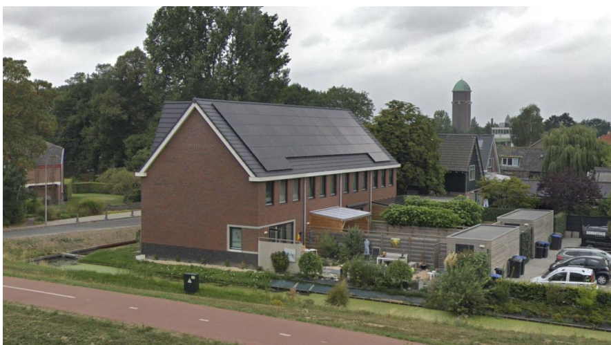
Nieuwe woningen Dijklaan, dakvlak voorzien van zonnepanelen
