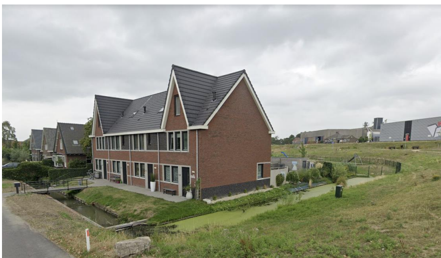
Nieuwe woningen Dijklaan, kopgevel alleen raam begane grond
