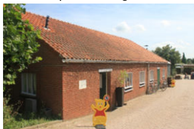
Het te slopen entreegebouw.
