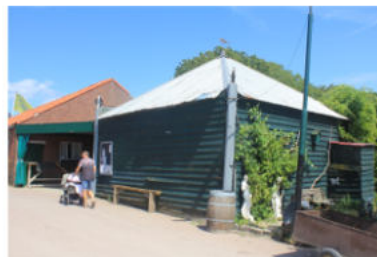
De te renoveren hooiberg.
