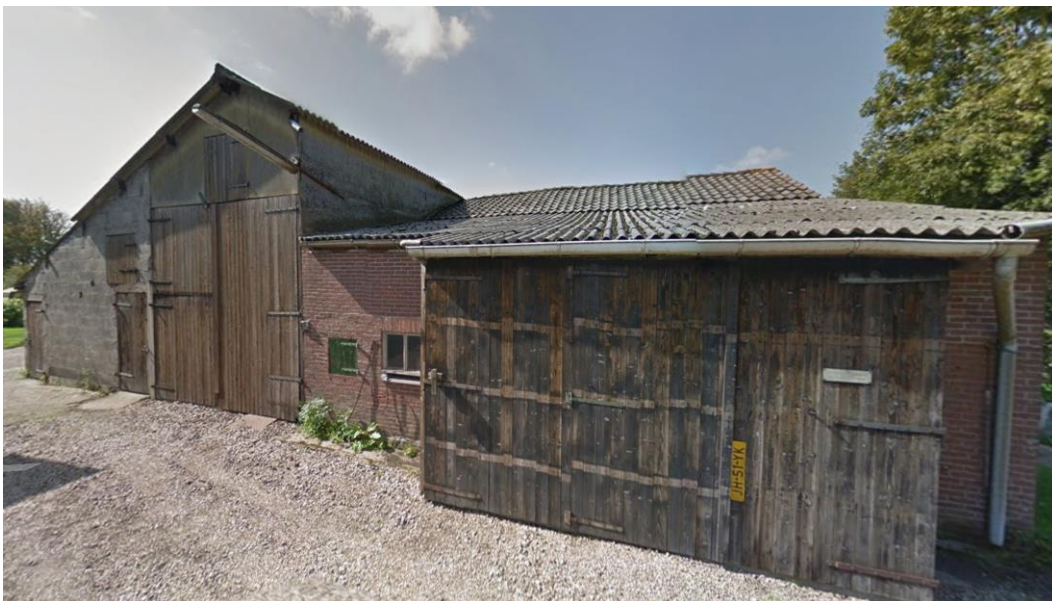
Figuur 2.3: te slopen schuurruimte
