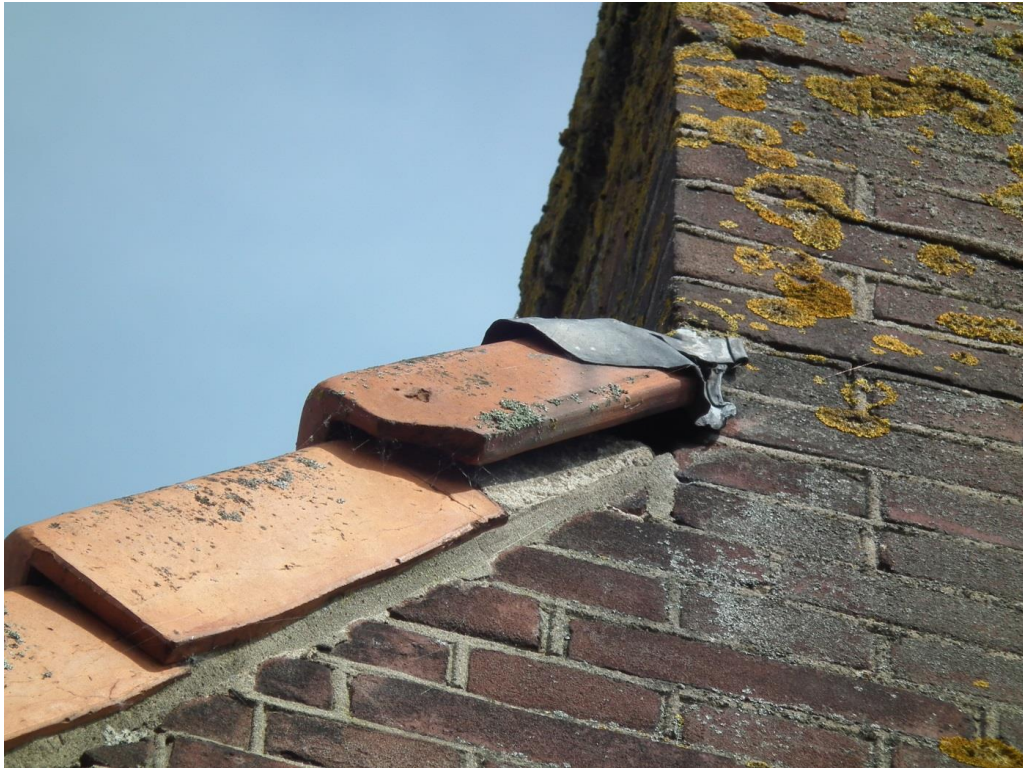
Figuur 3 Bij het kaaspakhuis zijn enkele suboptimale zomerverblijfplaatsen aangetroffen ten behoeve van vleermuizen. De daken zijn voorzien van vogelschroot.
