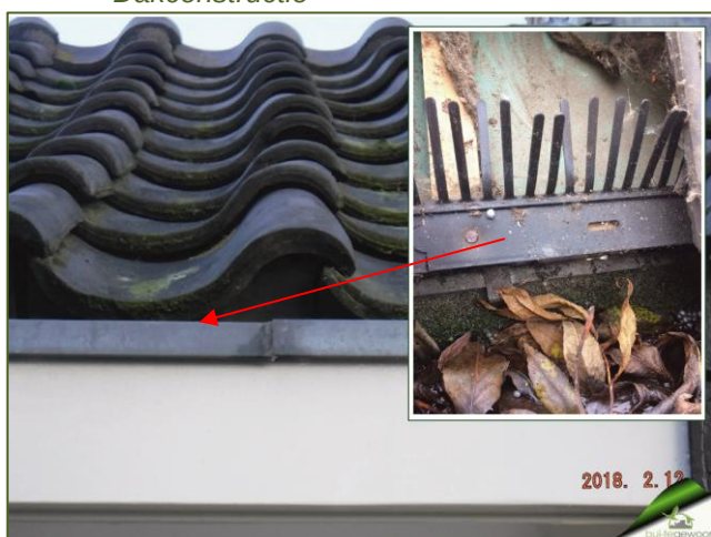
Gootafdichting fauna intrede voor eerste pannenlaag
